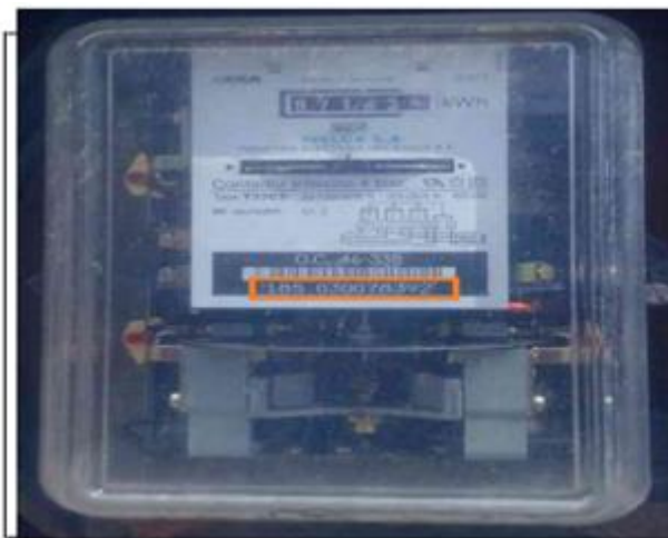
Figura 1,2. Se evidencia en terreno Medidor No 30078392 con sello roto en caja de conexiones.
